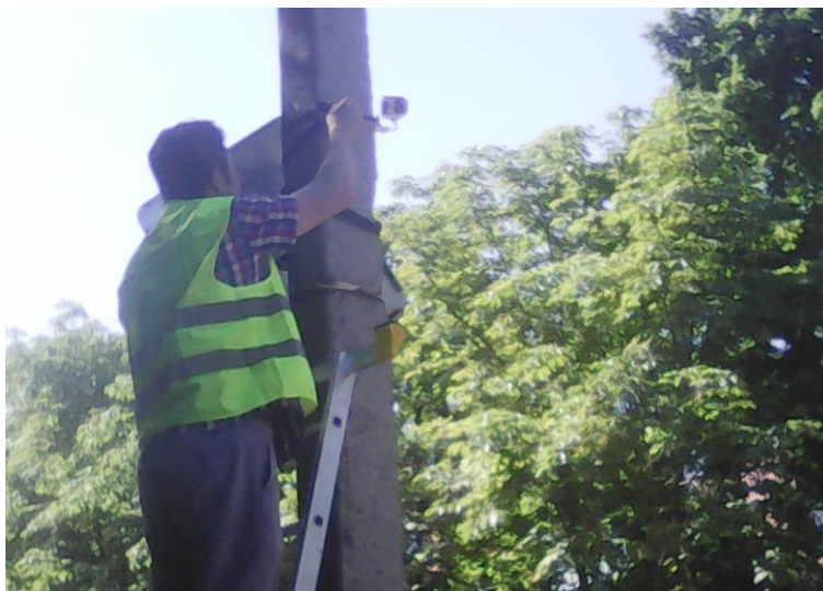
Рисунок 1 – Монтаж видеокамеры на столб линии электроосвещения
