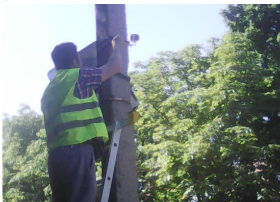
Рисунок 9 – Монтаж видеокамеры на столб линии электроосвещения
